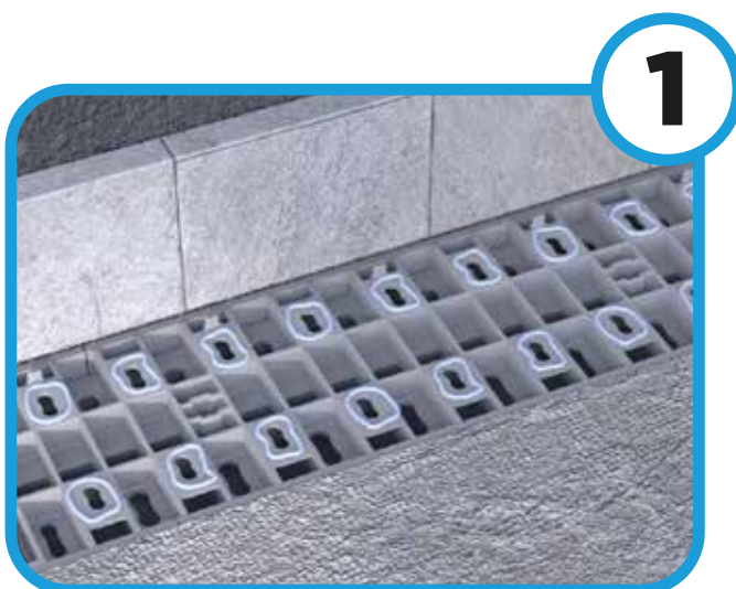
1 Posizionare la griglia con i perni rivolti verso l'alto.
