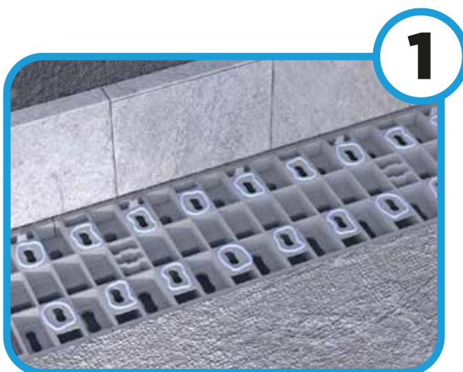
Posizionare la griglia con i perni rivolti verso l'alto.
